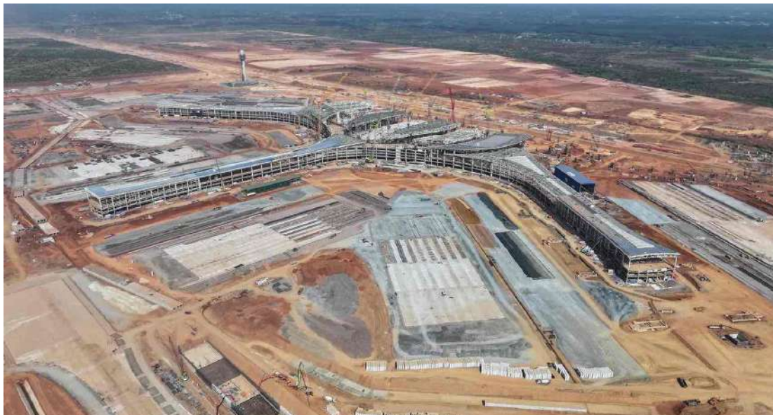
Hình 3.5. Sân bay Long Thành trong giai đoạn hoàn thiện
